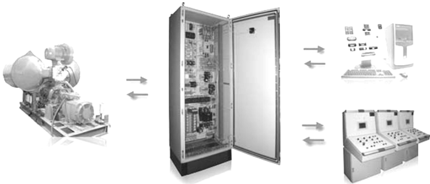
Рис. 1. Монтаж систем управления
