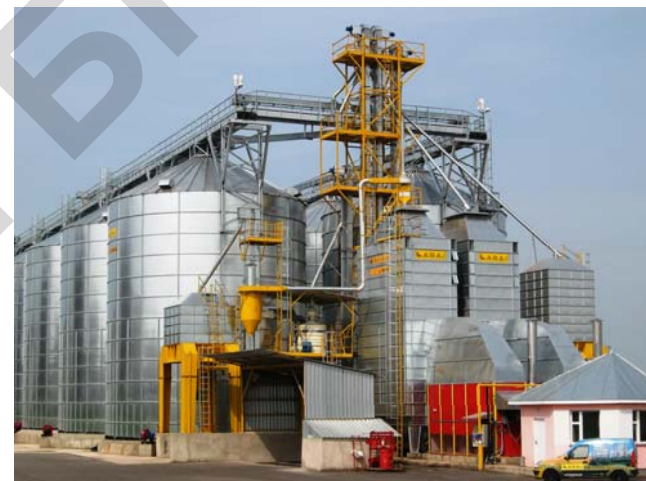
Рис. 5.14. Общий вид шахтной сушильной установки в составе зерносушильного комплекса
