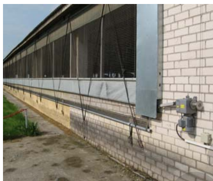
Рис. 4.96. Естественная вентиляция через боковой занавес
