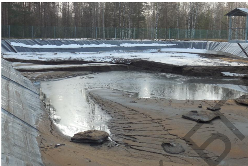
Рисунок 1 - Донный осадок, образовавшийся за три года эксплуатации лагуны
