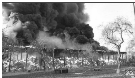
Рисунок 5 – Пожар в г. Кировске Могилевского района
